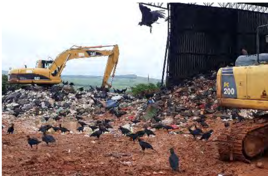
Foto 1 - Estação de Transbordo de Amparo.
