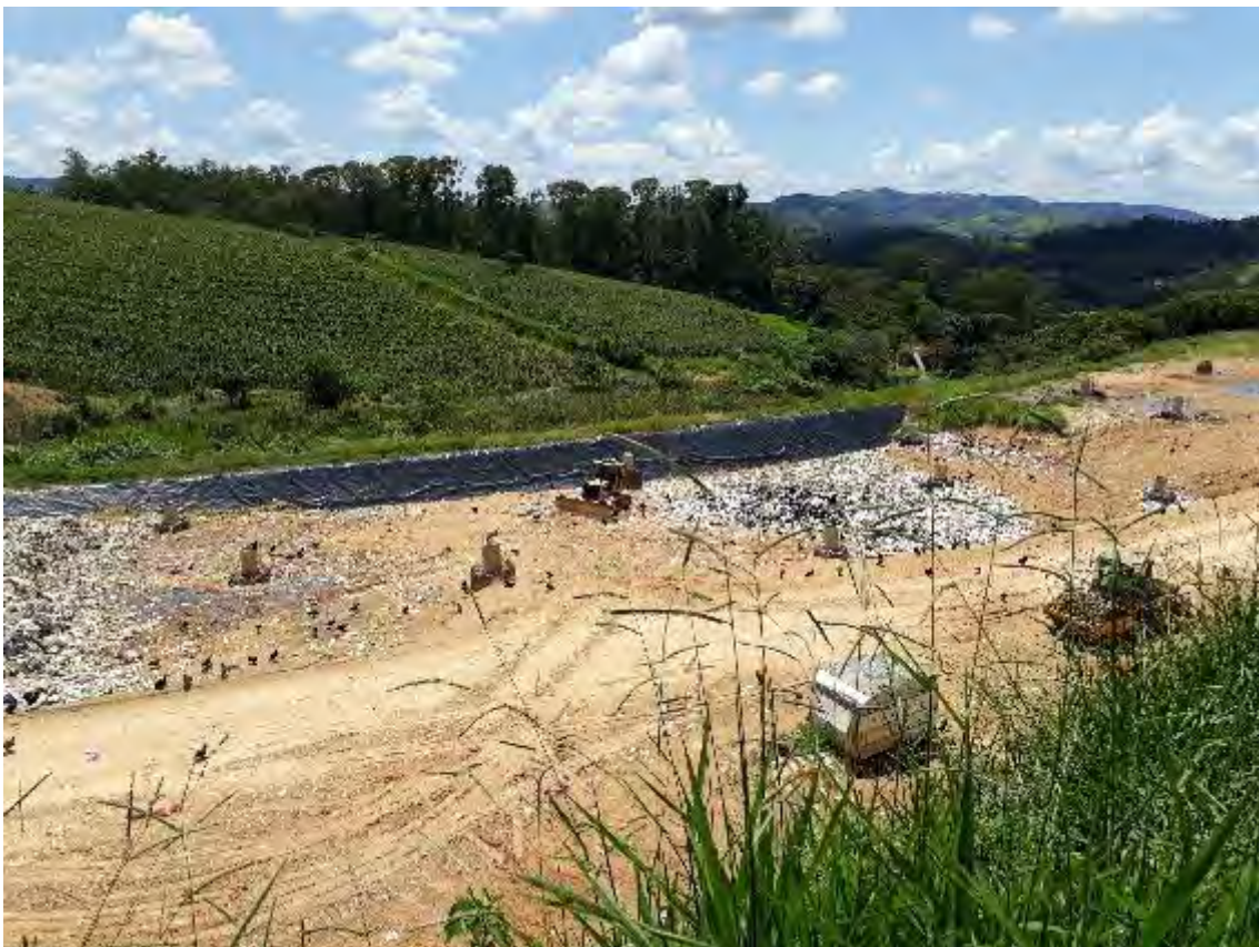
Foto 3 - Aterro Sanitário de Socorro.
