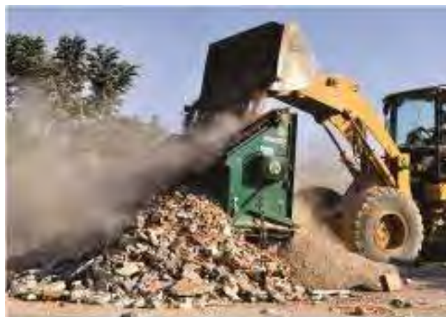
Foto 19 - Operação com a peneira vibratória do CISBRA.
