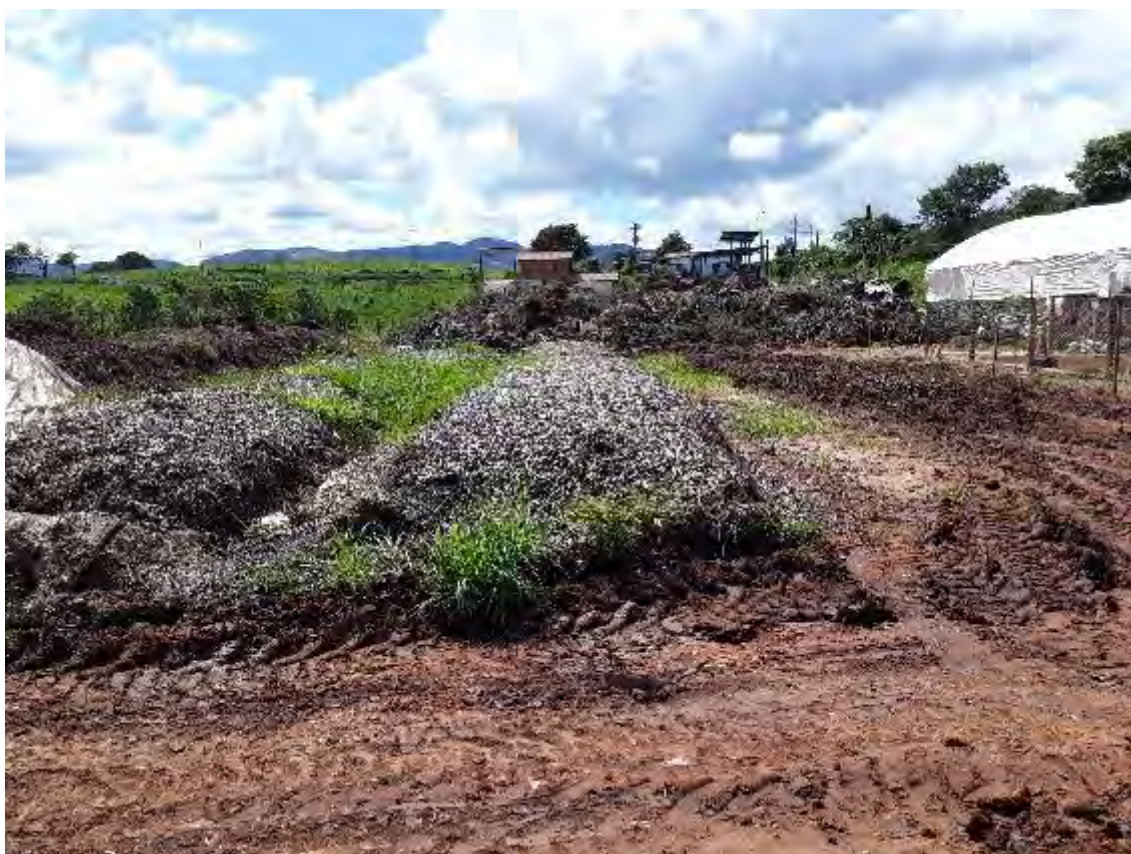
Foto 11 - Compostagem em leiras a céu aberto, no Complexo Ambiental de Socorro.
