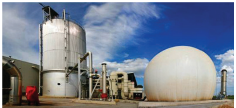
Figura 20 TMB – segregação das embalagens e biodigestão seca dos orgânicos
