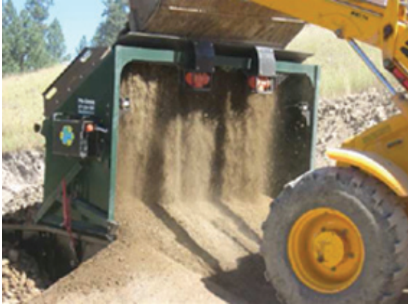
Figura 22 Equipamentos móveis – peneira vibratória e unidade de reciclagem
